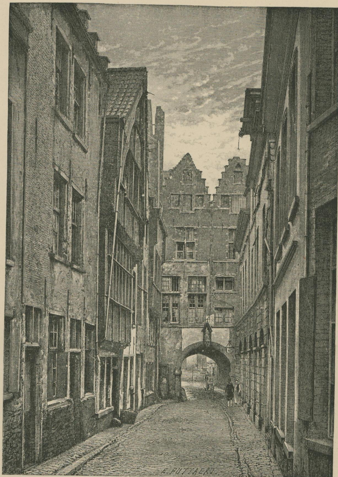
LE PONT AUX ANGUILLES DÉMOLI EN 1882
